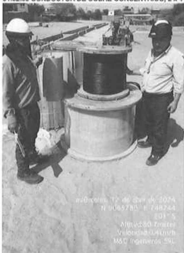
01.02.08 CONDUCTOR DE COBRE CONCENTRICO, 2 x 4 mm 2 , CON AISLAMIENTO Y CUBIERTA DE PVC
